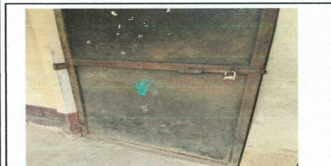
Foto 5: Se realizará mantenimiento a las puertas.
