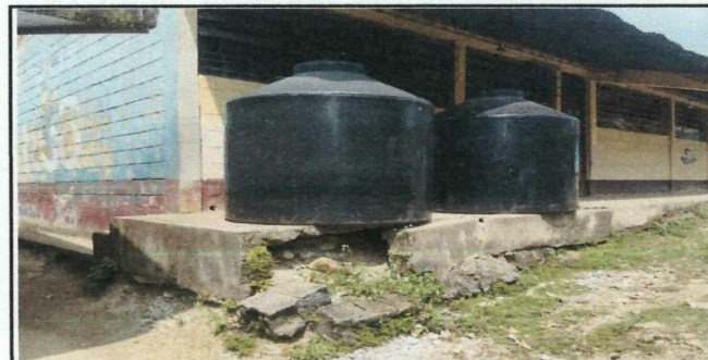
Foto 6: Se reparará el piso del pacillo y se realizará la base para los tinacos utilizados para el almacenamiento de agua del centro educativo.
