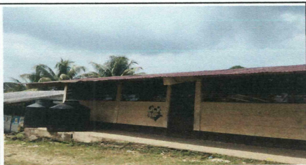
Foto 3: Vista frontal del modulo de aulas a reparar, se sustituirá la estructura y cubierta de lamina, se repararán las puertas y ventanas con el objetivo de crear un ambiente mas digno y saludable para los niños y niñas.
