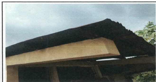
Foto 3: Se observa el deterioro de la estructura de techo de metal, se realizará mantenimiento correctivo.
